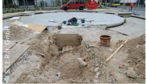
Während der Sanierung
